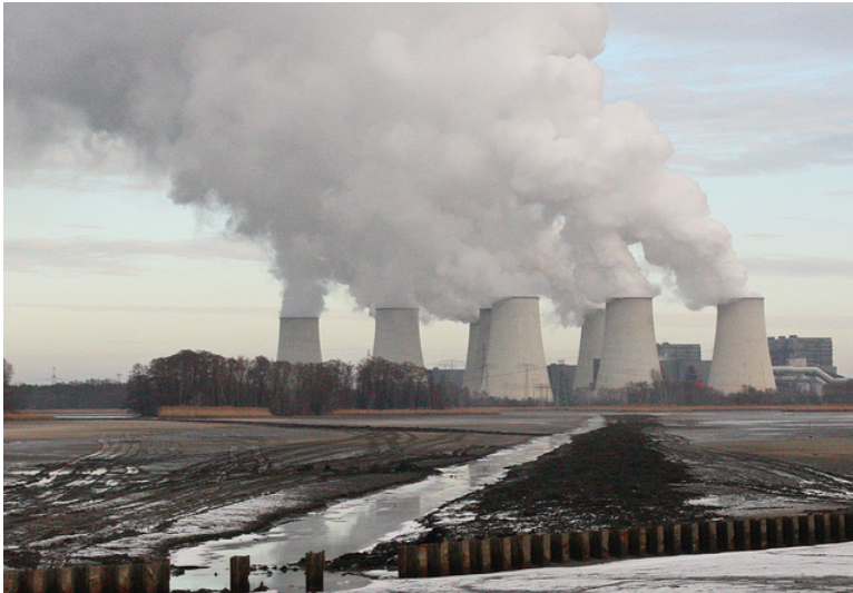
Haben bald ausgesiedet: Braunkohlekraftwerke wie hier
