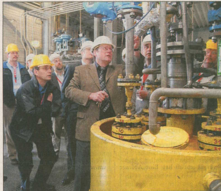
Teilnehmer der Freiburger Konferenz schauten sich gestern in der Firma Siemens Fuel Gasification Technologies GmbH um. —FOTO: ECKARDT MILDNER
