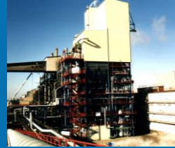
Sustec Schwarze Pumpe GmbH
